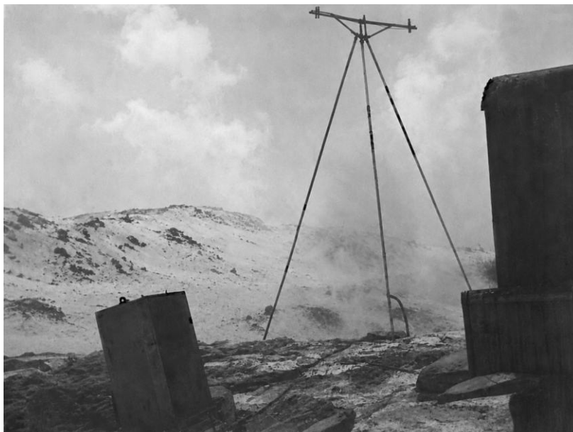
Dispositivo di nebulizzazione storico di Hans Hangartner durante la missione in India nel luglio 1988. La semplice costruzione era composta da diversi tubi di nebulizzazione disposti in alto e veniva impiegata per la fine nebulizzazione dell'acqua. [4]
